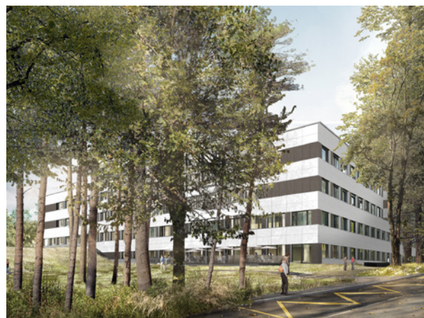
Blick von der Geissbergstrasse auf den Neubau.
